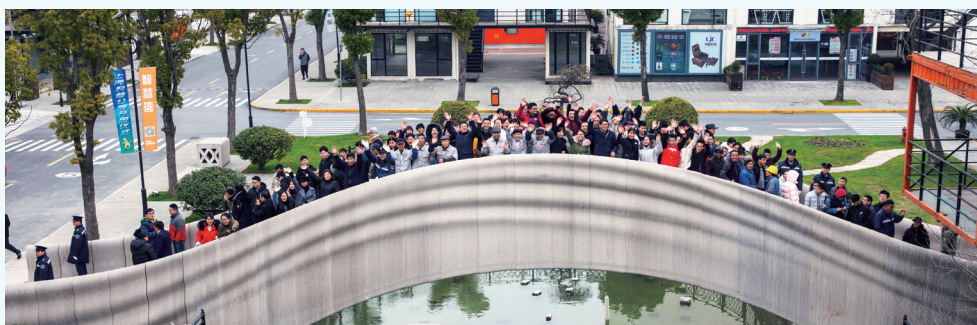
▲ 清华徐卫国教授团队在上海宝山建成目前世界最大混凝土3D打印步行桥
